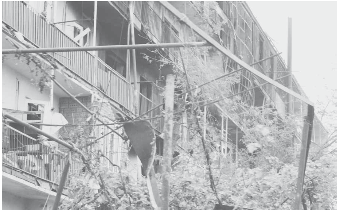
Zerstörtes Haus in Gori
